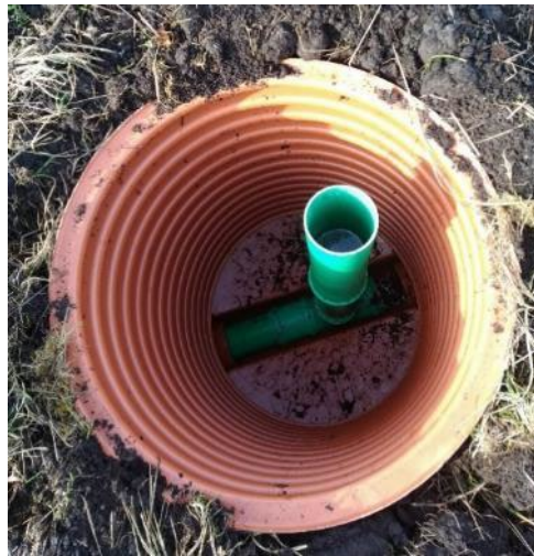
Abbildung 2.16: Kunststoffschacht mit abnehmbaren Rohraufsatz (L: 40 cm) im Klosterland Benediktbeuern.
