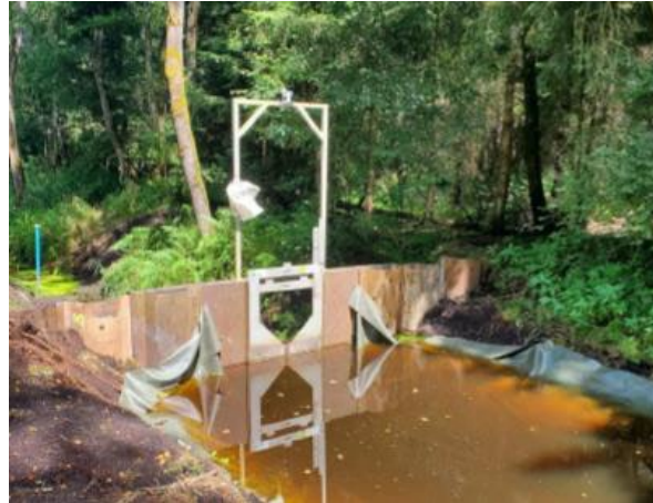
Abbildung 2.5: Das Messwehr im Erlbach, dem zentralen Vorfluter auf der Versuchsstation Karolinenfeld. Der Ablauf wird durch einen Schieber verschlossen, um das Messwehr in ein Stauwehr umzuwandeln.
