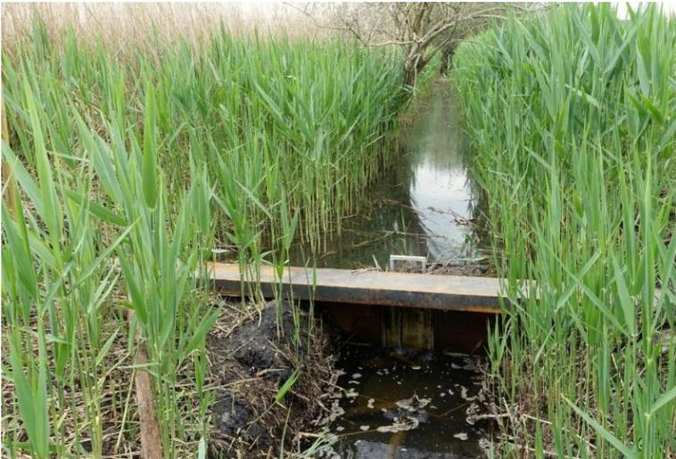
**Abbildung 1:** Mit einem Stauwehr lässt sich der Grabenwasserstand zuverlässig anheben und über einen Schieber regeln (Foto: LfL).
