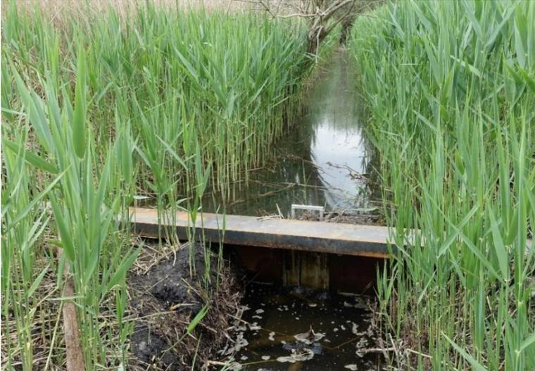
Abbildung 1: Mit einem Stauwehr lässt sich der Grabenwasserstand zuverlässig anheben und über einen Schieber regeln (Foto: Bastian Zwack, LfL).
