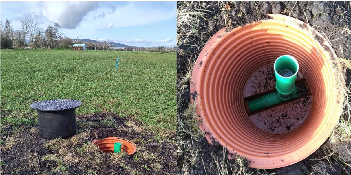
Abbildung 2: Auf stärker geneigten Flächen helfen kleine Stauschächte einen möglichst einheitlichen Grundwasserstand einzustellen (Fotos: Lennart Gosch und Eva Schmidt, LfL).
