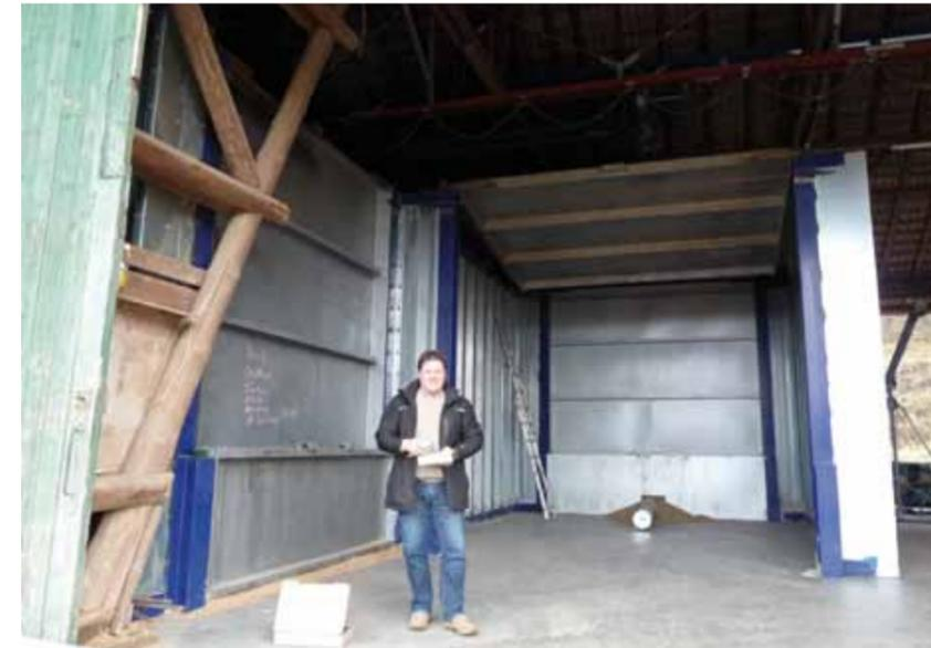
Christoph Förster vor einem entleerten Segment mit hochgeklappter Frontwand und sichtbarem Belüftungsrohr. Links ein verschlossenes Segment bestehend aus unten eingeschobenem Trennwandelement, welches zur Entleerung mit dem Radlader entfernt wird. Foto: Niklas Wawrzyniak
