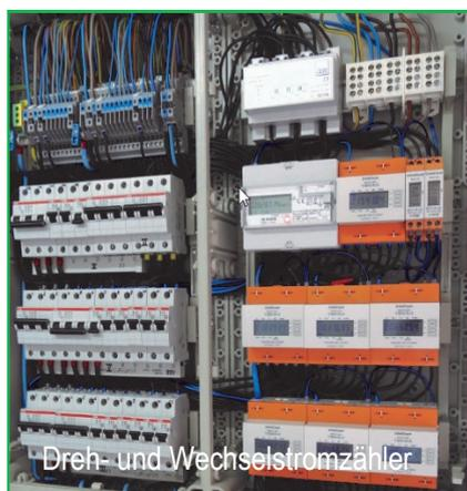
Dreh- und Wechselstromzähler
