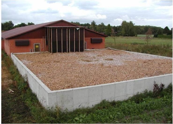
Biofilter links: Wurzelholzschüttung, modularer Aufbau, Werkstoff: Edelstahl. Rechts: Strohbett mit Holzhackschnitzel (Fotos: KTBL)
