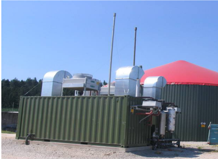
Abb. 5: Foto des BHKW 4 (110 kW el. Zündstrahl-Motor) im Container vor dem Fermenter mit Gas-speicher
