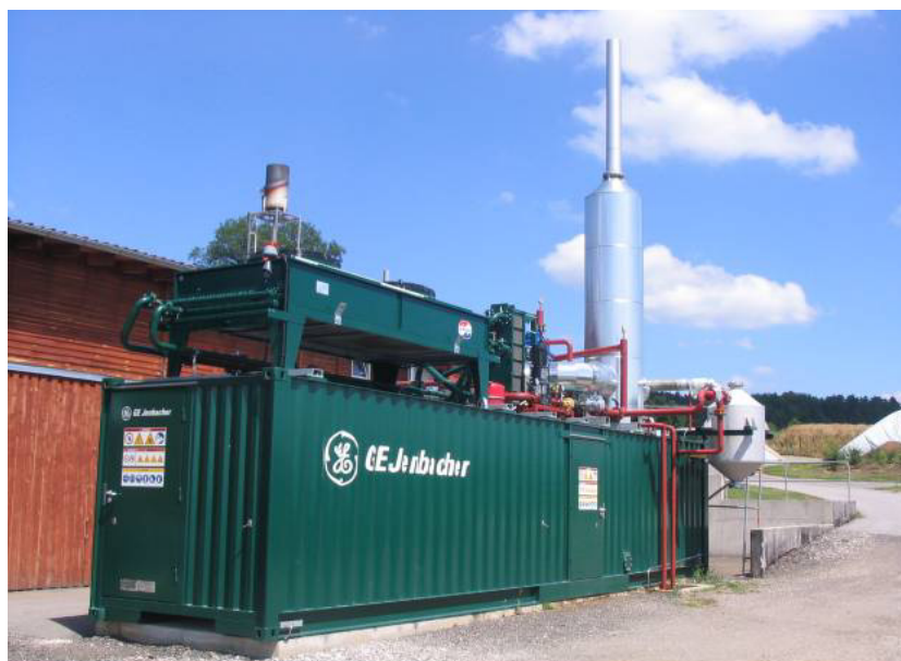
Abb. 4: Foto des BHKW 3 (526 kW el. Gas-Otto-Motor) im Container
