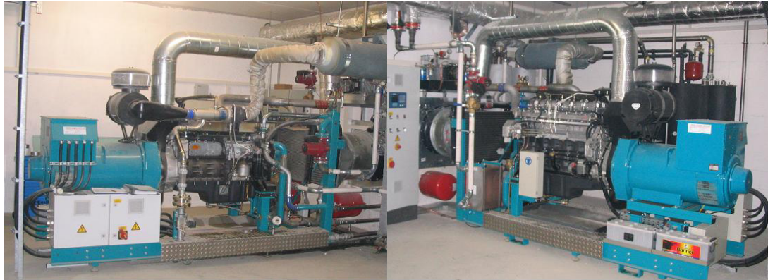
Abb. 6: Fotos der BHKW 5 und 6 (250 kW el. und 265 kW el. Zündstrahl-Motoren)
