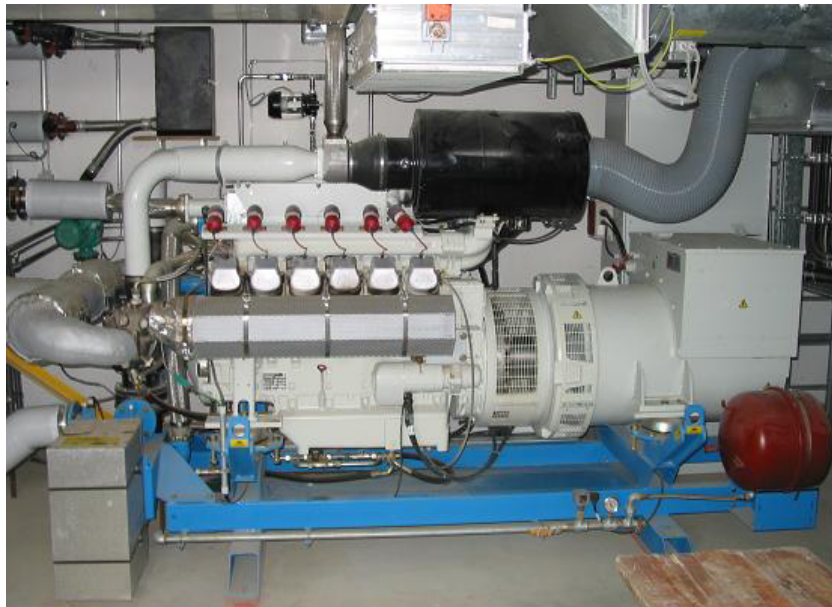
Abb. 3: Foto des BHKW 2 (324 kW el. Gas-BHKW)
