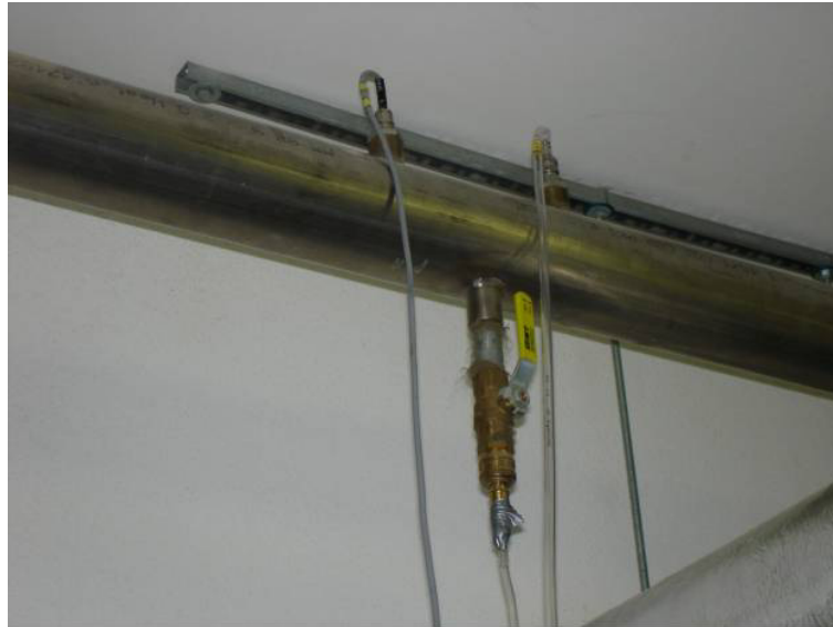
Abb. 9: Messstutzen für die Messung von Gaszusammensetzung, - druck, –temperatur und –feuchte
