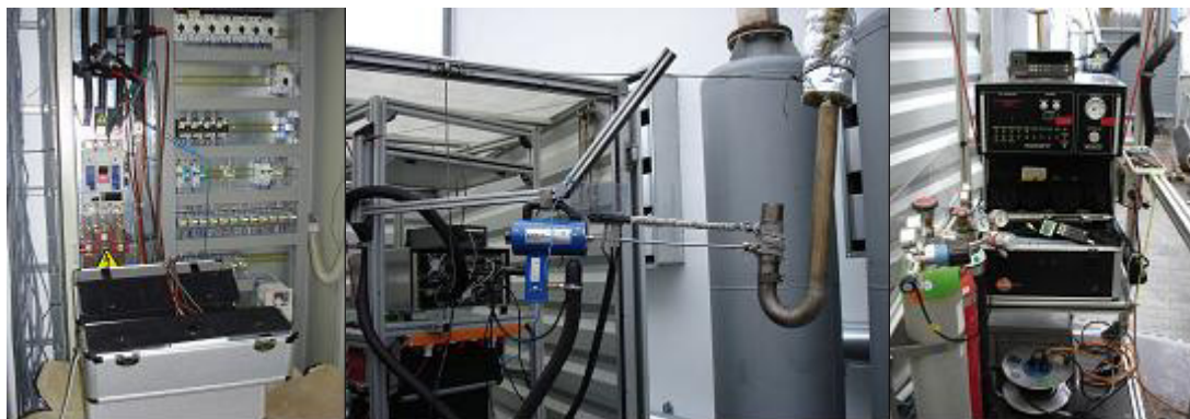
Abb. 11: Messgeräte für Leistung und Abgaszusammensetzung im Praxiseinsatz
