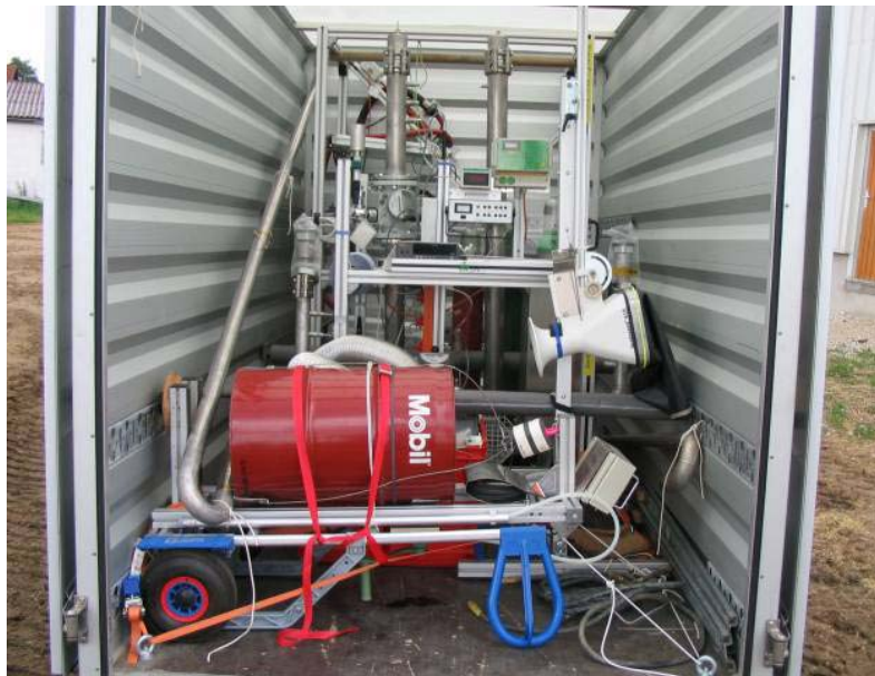
Abb. 14: Mobile Messeinrichtung zur Überprüfung von Biogas – BHKW
