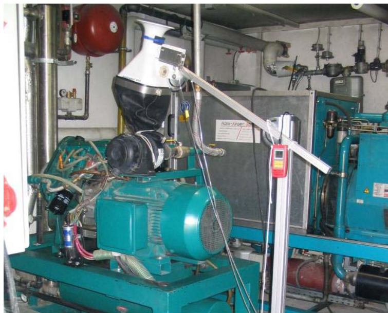
Abb. 10: Messung der Zuluftmenge in der Praxis
