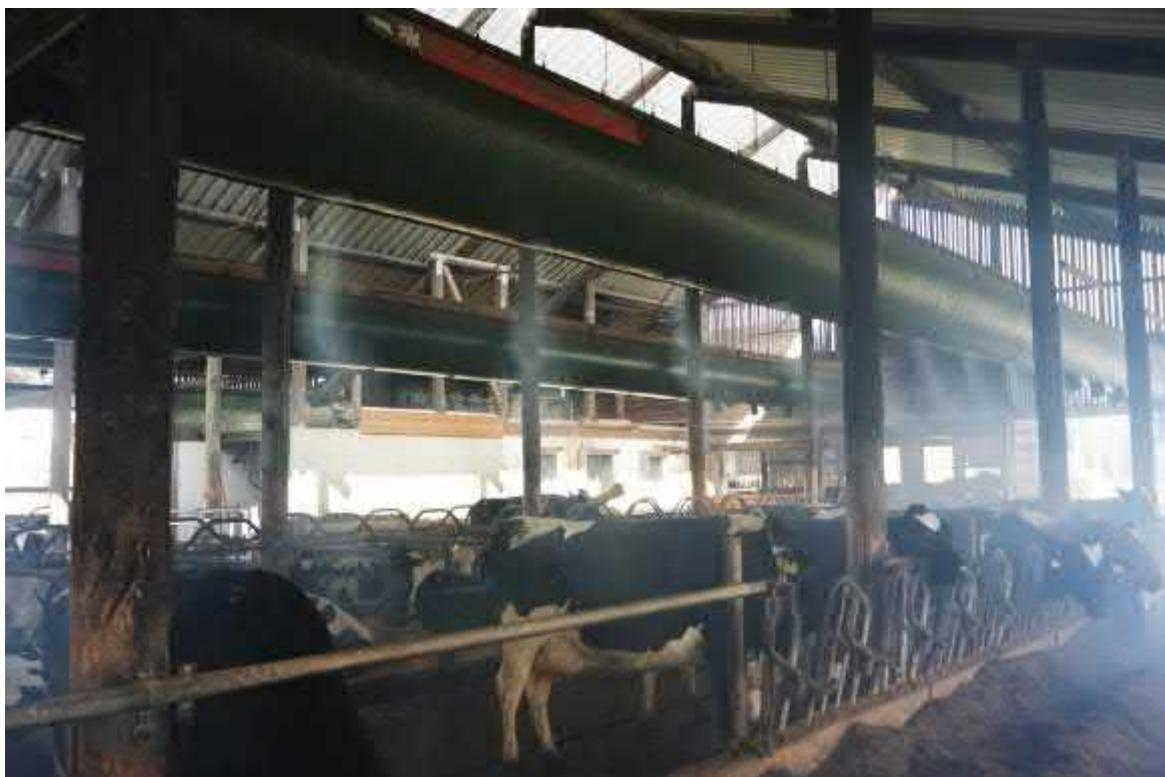
*Abb. 11: Einsatz einer Vernebelungsmaschine zur Visualisierung des Luftstroms bei laufender Schlauchlüftung (Betrieb A)*
