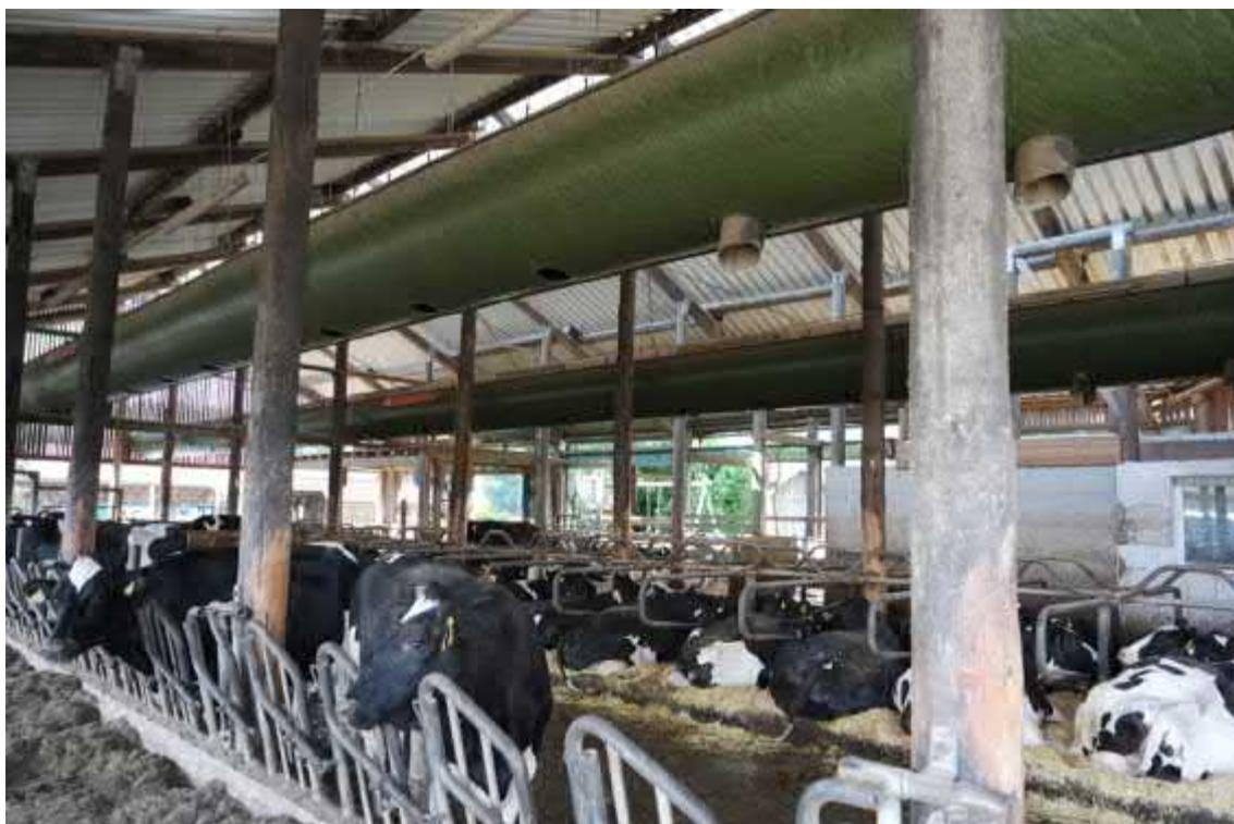
*Abb. 10: über Futtertisch und Liegeboxen installierte Schlauchlüftung / -kühlung (Betrieb A)*
