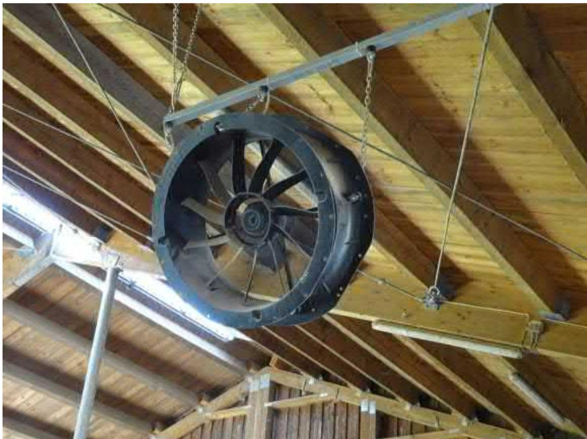
*Abb. 22: Ventilatorenbefestigung über wandständiger Liegeboxenreihe*
