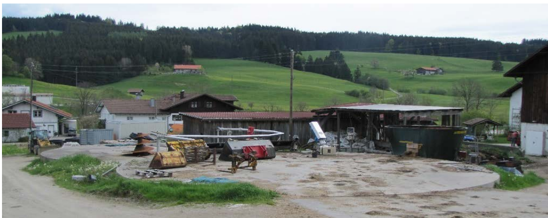
Abb. 8: Pilotanlage 20: Fermenter (Vordergrund), Gasleitung und Nachgärbehälter (linke Bildmitte)
