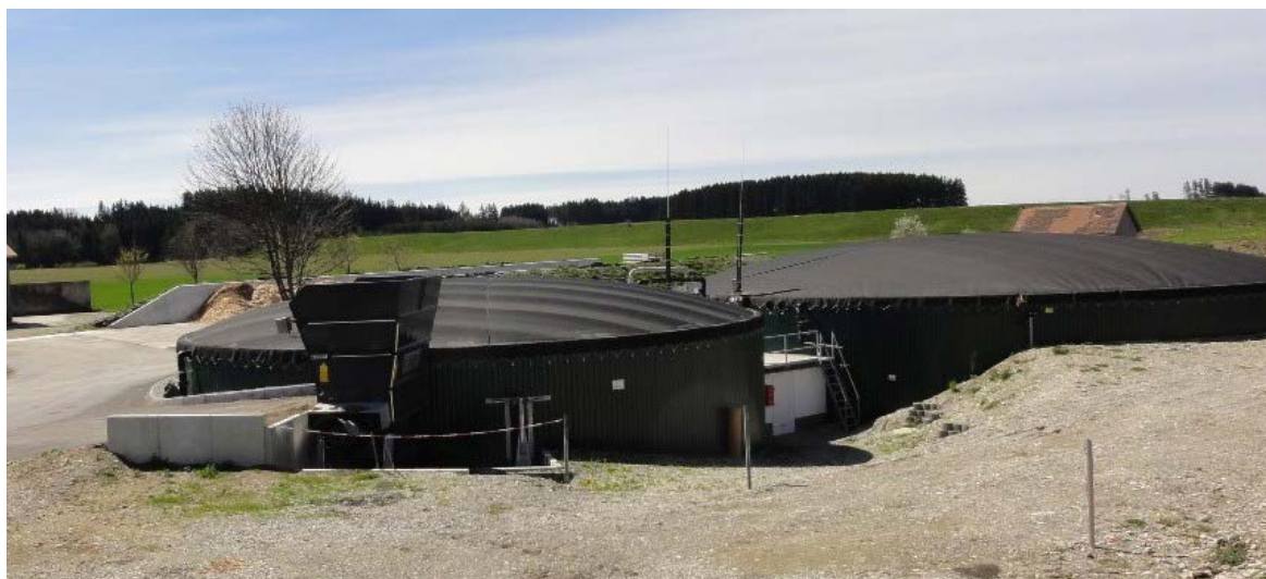
Abb. 4: Ansicht der Pilotanlage 18 mit Eintragstechnik, Fermenter und Gärrestlager
