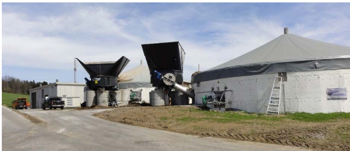
Abb. 10: Fermenter (rechts) und Nachgärbehälter (Bildmitte) auf Pilotbetrieb 21
