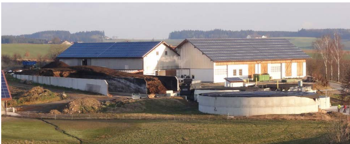
Abb. 2: Pilotbetrieb 17: Fermenter und Gärrestlager (rechts vorne); Fahrsilo (linke Bildmitte)
