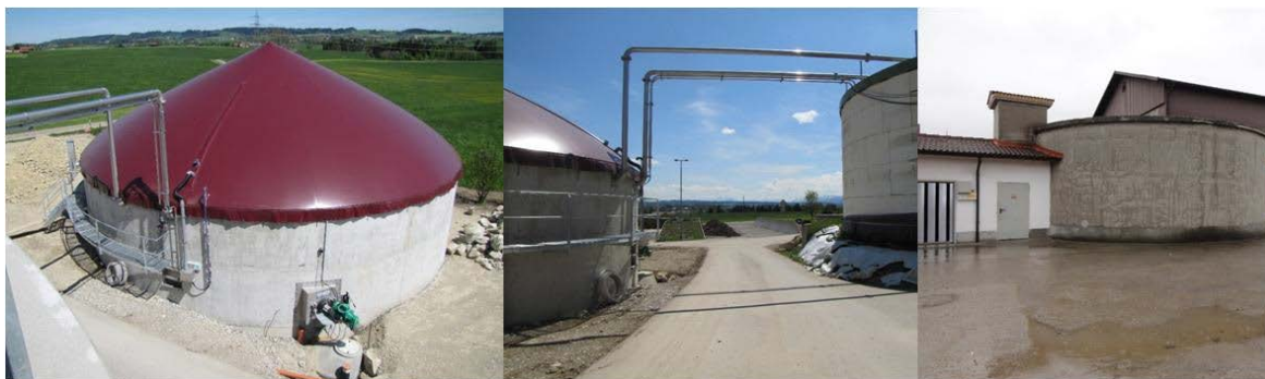
Abb. 6: Biogasanlage auf Pilotbetrieb 19: Fermenter (links), Biogasleitung (Mitte) und Nachgärbehälter (rechts)
