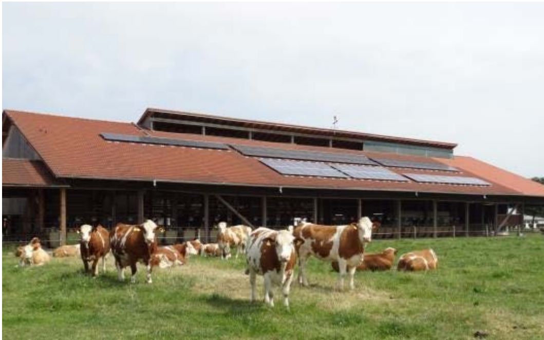
Abbildung 1: Photovoltaikanlage in Grub
