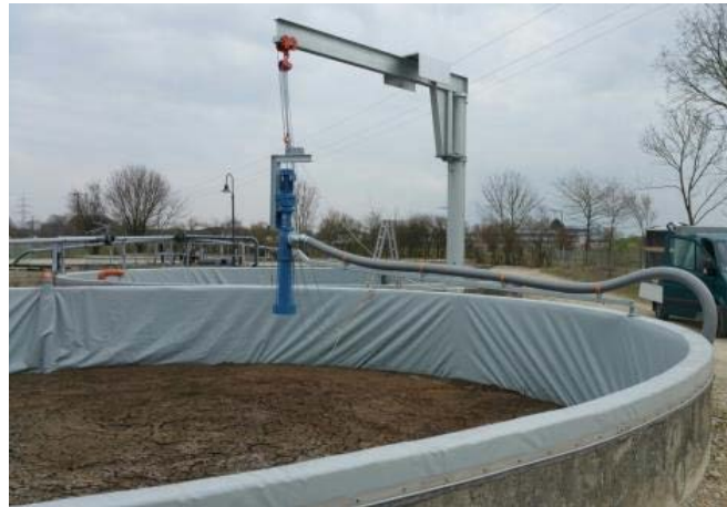
Abbildung 6: Befestigung der Zuckerrübenpumpe am Kran
