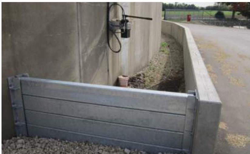
*Umwallung an einer Biogasanlage*
