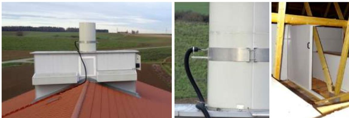
*Messzugänge am Stalldach (links), Anschluss der beheizten Messgasleitung (Mitte), Schieber zur Trennung der Luftströme im Abluftkanal (rechts)*
