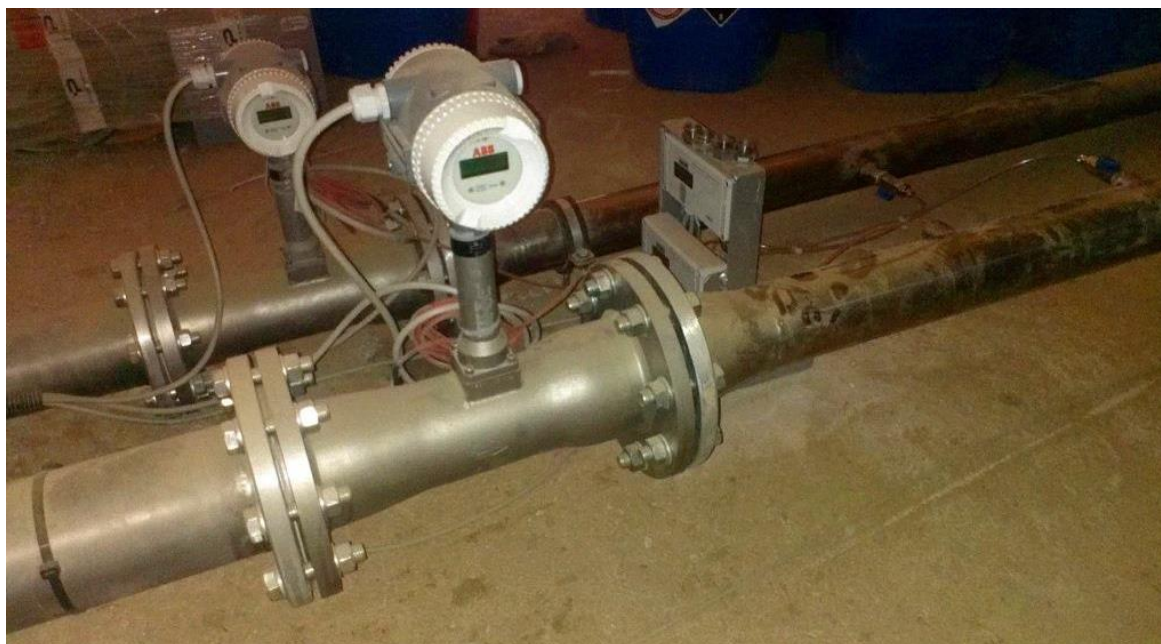
Abbildung 1: Drallzähler für die Gasmengenerfassung auf Pilotanlage #12
