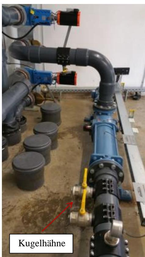
Abb. 11: Integrierte Kugelhähne
