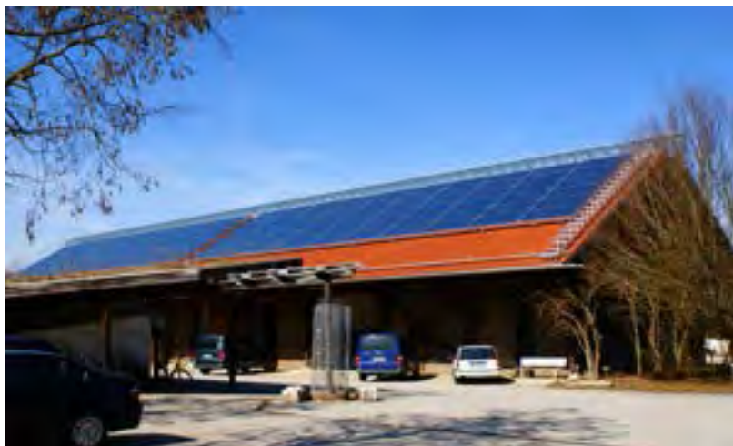
Abbildung 3: Luftkollektoren auf der Trocknungshalle der LfL
