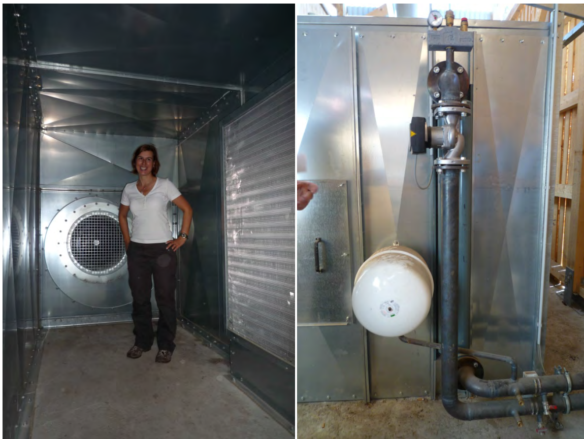
Abbildung 7: Wärmetauscher und Radialventilator mit KWK-Nutzung
