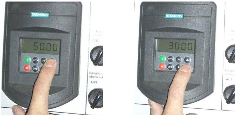
Abbildung 5: Drehzahlveränderungen (50 Hz = 2940 U/min; 30 Hz = 1790 U/min)
