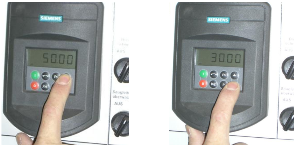
Abb. 5: Drehzahlveränderungen (50 Hz = 2940 U/min; 30 Hz = 1790 U/min)
