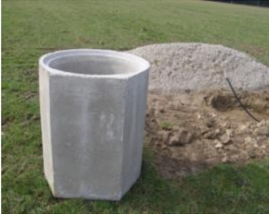
Am geplanten Standort sollte nun idealerweise der Humus in einem Bereich von etwa zwei Meter abgeschoben werden. In diese abgeschobene Fläche wird ein 80 cm langes Betonrohr mit einem Innendurchmesser von 80 cm etwa 20 – 30 cm tief stehend eingegraben. Die Wasserzuleitung befindet sich innerhalb des Betonrings (Bild 8).
