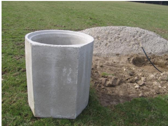
Bild 10: Vorbereitung einer Tränkestelle
