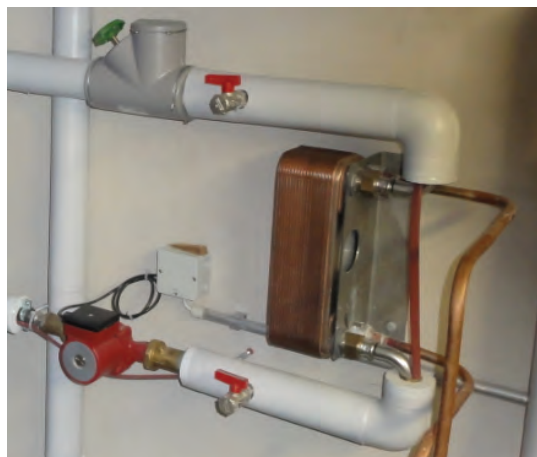
Abb. 6: Plattenwärmetauscher
