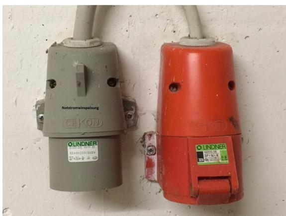
Abb. 13: Sichere Notstromspeisung in das Stromnetz eines Gebäudes. Foto: I. Brandmüller, LRA Altötting
