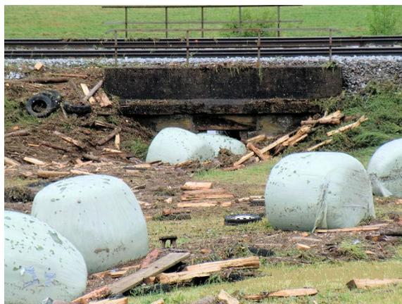
*Abb. 7: Verklauung eines Durchlasses unter einer Bahnlinie mit Silageballen und Holz
