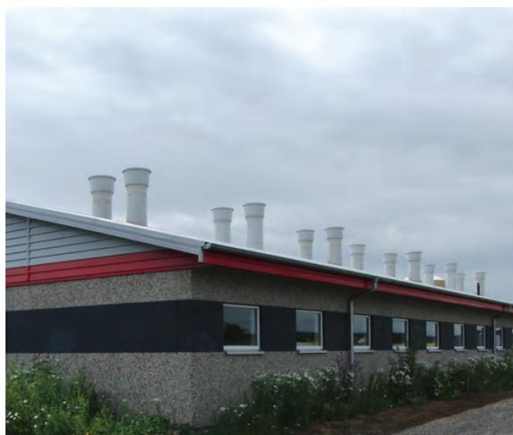
Abb. 9: Dezentrale Abluftführung
