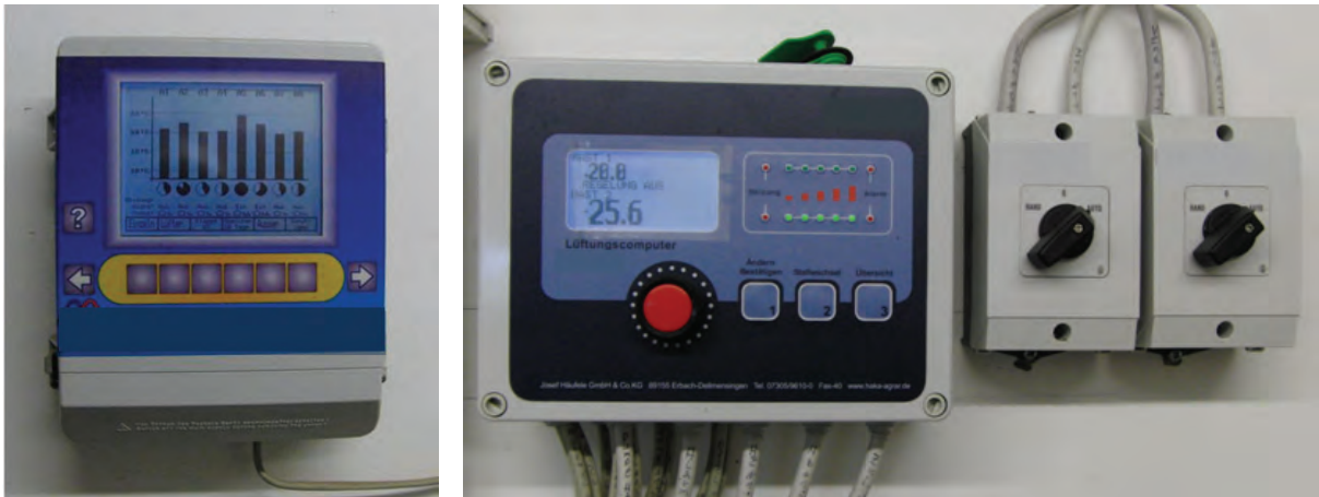
Abb. 10: Lüftungsregelung - Lüftungscomputer
