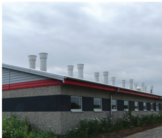
Abb. 9: Dezentrale Abluftführung
