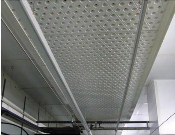
Abb. 6: Zuluftführung über Porenkanäle
