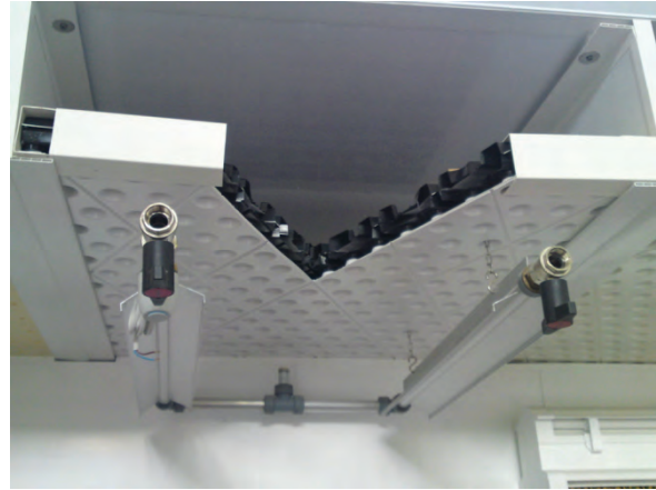
Abb. 7: Schnitt Porenelement
