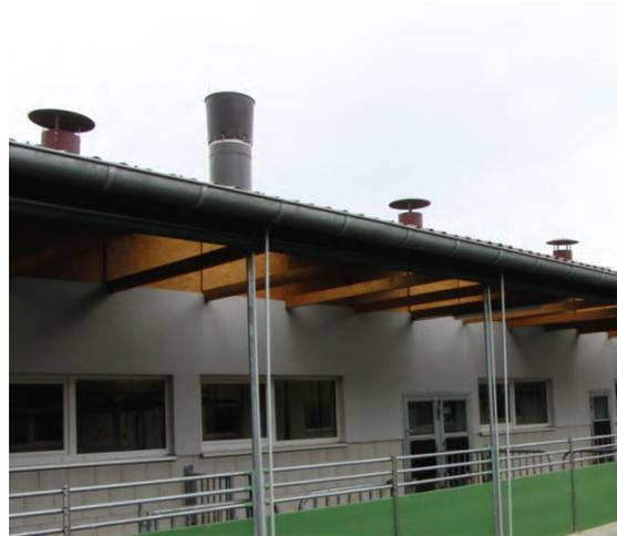
Abb. 12: Abluftkamine mit Abdeckhaube bzw. Diffusor
