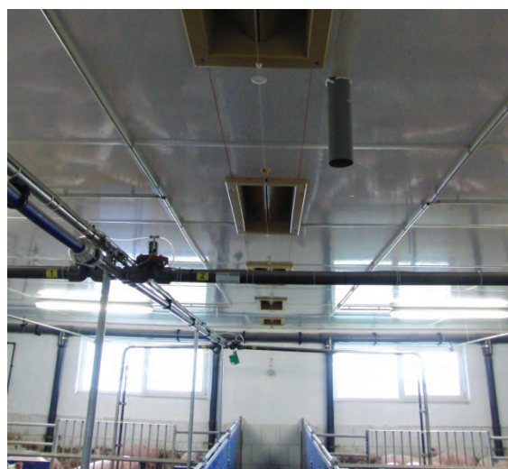
Abb. 5: Deckenventile
