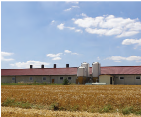
Abb. 8: Zentrale Luftabsaugung
