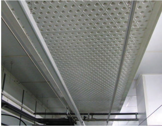
Abb. 6: Zuluftführung über Porenkanäle
