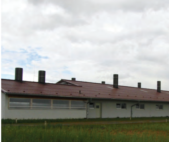
Abb. 11: Runde Abluftkamine
