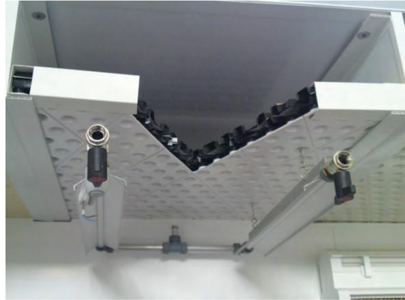
Abb. 7: Schnitt Porenelement
