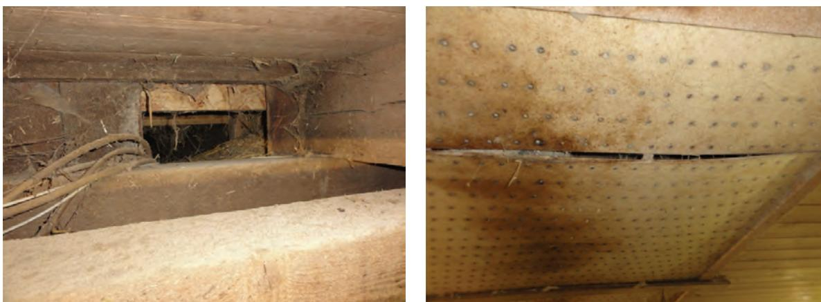
*Abb. 13: Zu kleine, verschmutzte Zuluftkanäle und verstopfte Porenplatten erhöhen neben der Staubbelastung den Energieverbrauch der Lüftungsanlage.*
