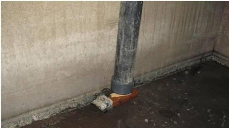
Abb. 46: Abgedichtete Spülleitung im Güllekanal
