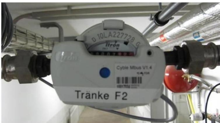
Abb. 54: Wasseruhr für das Tränkwasser im Ferkelabteil F 2
