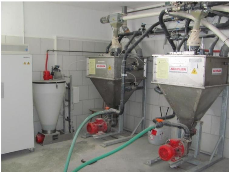
Abb. 15: Flüssigfütterungsanlage mit zwei getrennten Mischbottichen und Kreisläufen
