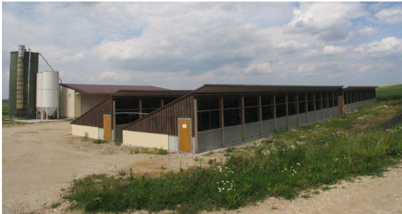
Abb. 2: Der Maststall, erstellt in der Bauart des Pig – Port, Typ I, aus Blickrichtung S-W
