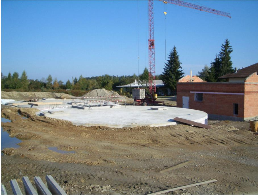
Abb. 9: 150 kW Anlage mit Fermenter und Nachgärbehälter im Hintergrund
