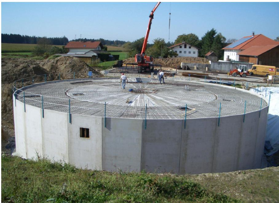
Abb. 10: Fermenter und Endlager „Topf in Topf“ mit 30 m Durchmesser
