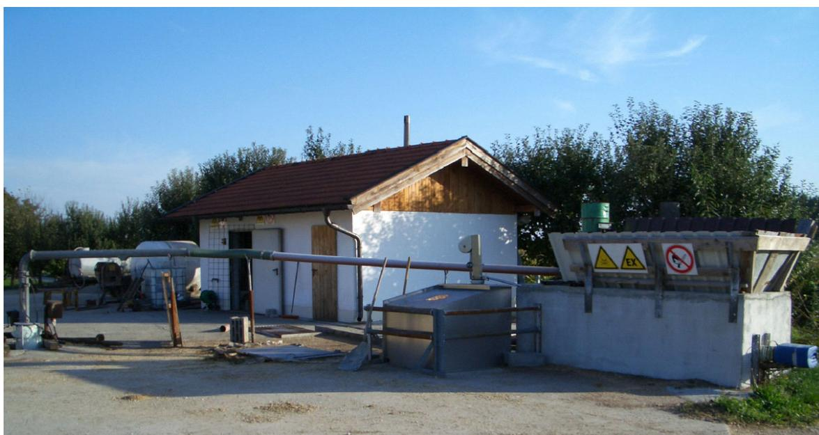
Abb. 2: Biogasanlage mit selbstgebauter Einspeisetechnik
