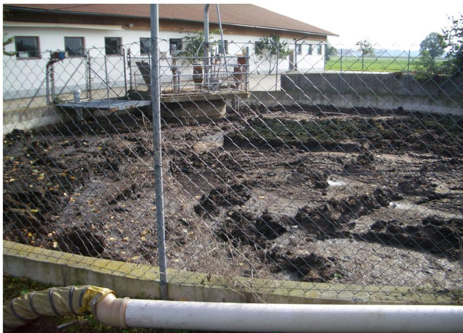
Abb. 6: Schwimmdeckenproblematik im Endlager
