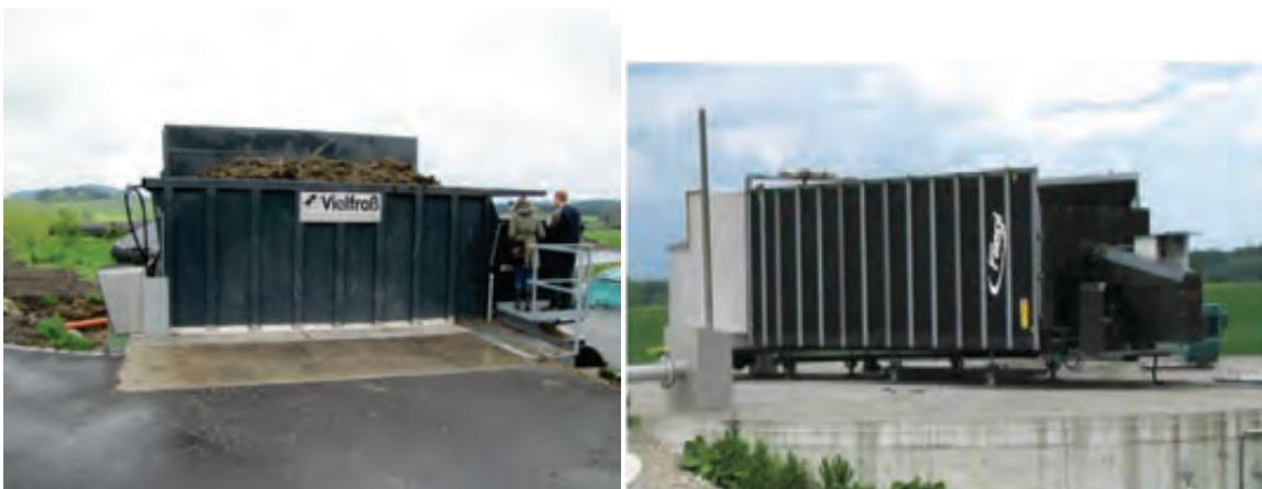
Abb. 32: links: Vorlagebehälter 50 m<sup>3</sup>; rechts: Großer Vorlagebehälter mit Abschiebetechnik
