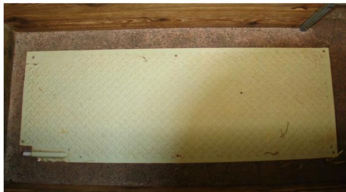
Abb. 4: Über ein Thermostat geregelte elektrische Bodenheizung im Ferkelnest
