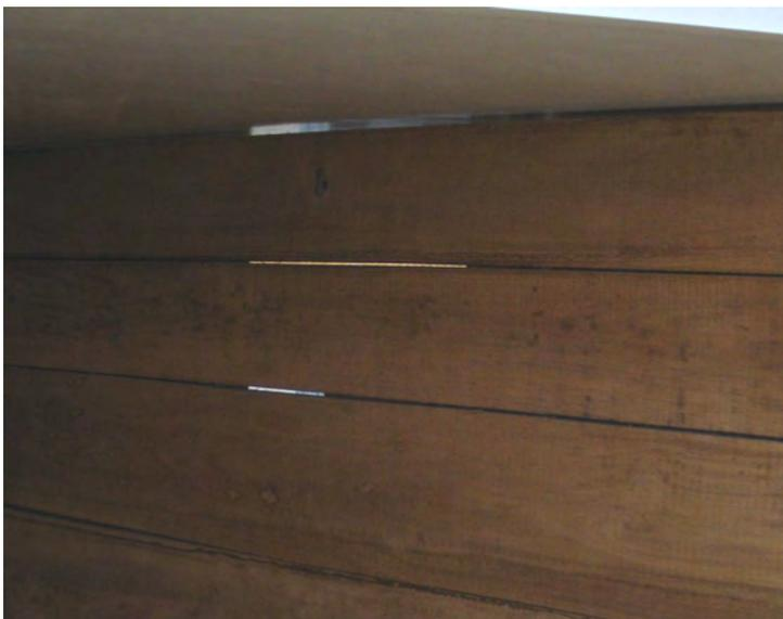
*Abb. 31: Lücken in den Buchtentrennwänden führen zu hohem Wärmeverlust*
