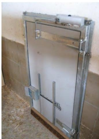
Abb. 32: Dichte Auslauftür mit Schließmechanismus und Schwelle
