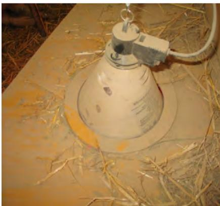
Abb. 3: Dicht abschließende Öffnung für den IR-Strahler
