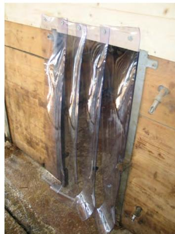
*Abb. 8: PVC-Streifenvorhang am Durchgang zum Mistgang*
