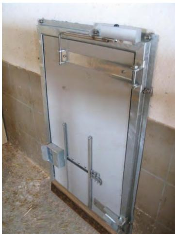
*Abb. 7: Neu eingebaute, dicht schließende Auslauftür*
