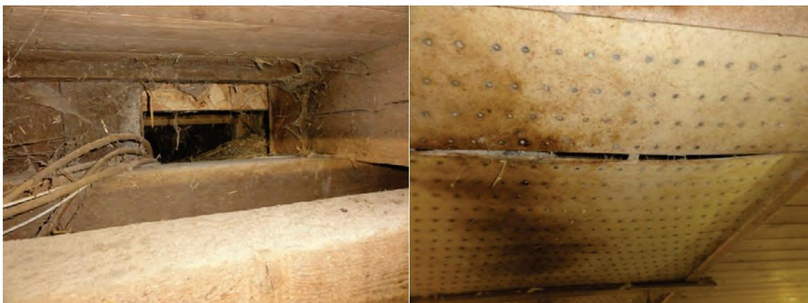
*Abb. 8: Unterdimensionierte, verschmutzte Zuluftkanäle und verstopfte Porenplatten als Ursache für schlechtes Stallklima und erhöhten Energiebedarf*
