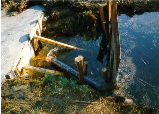
Abb. 8: Fertigstellung des Ablaufes mit einbetoniertem Kunststoffrohr
