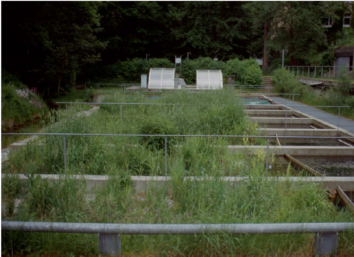
Einrichtungen zur Ablaufwasserreinigung am Institut für Fischerei in Starnberg: Pflanzenkläranlage mit vorgeschalteten Absetzbecken (Vordergrund) und Mikrosieb (Hintergrund)
