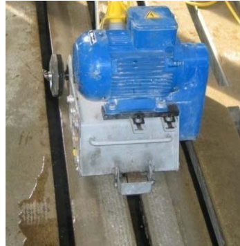
Chemisches und mechanisches Verfahren zur Sanierung von Spaltenböden
