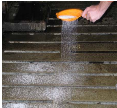
Chemisches und mechanisches Verfahren zur Sanierung von Spaltenböden
