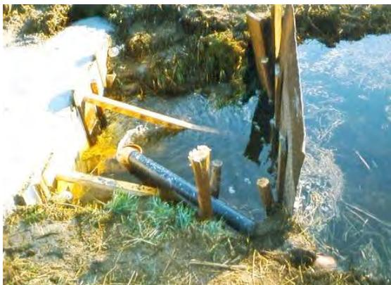
*Fertigstellung des Ablaufes mit einbetoniertem Kunststoffrohr*
